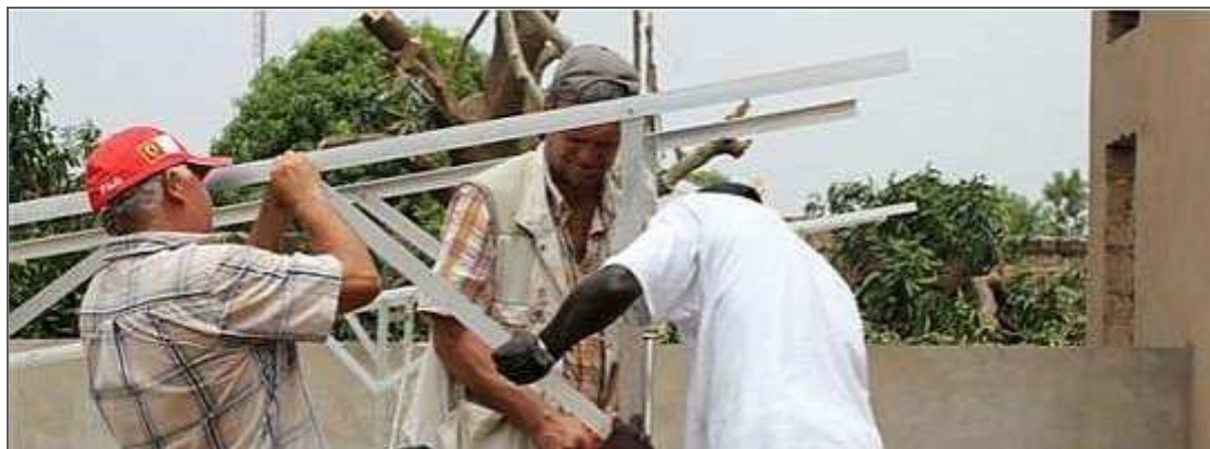
Projektmitarbeiter beim Aufbau der Solaranlage.
