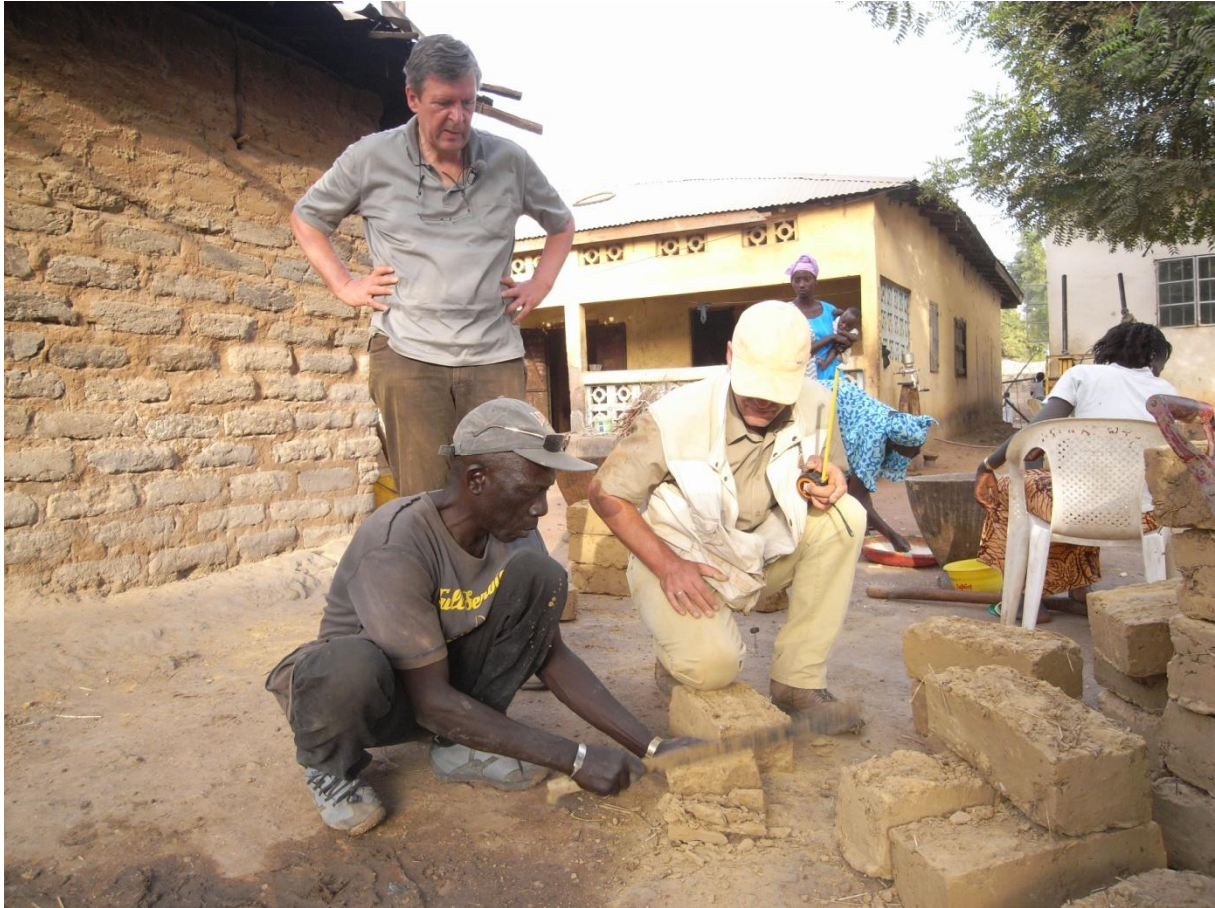
Jaja, der Zimmermann der Projekthilfe, behaut einen Lehmziegel mit einer Machete
