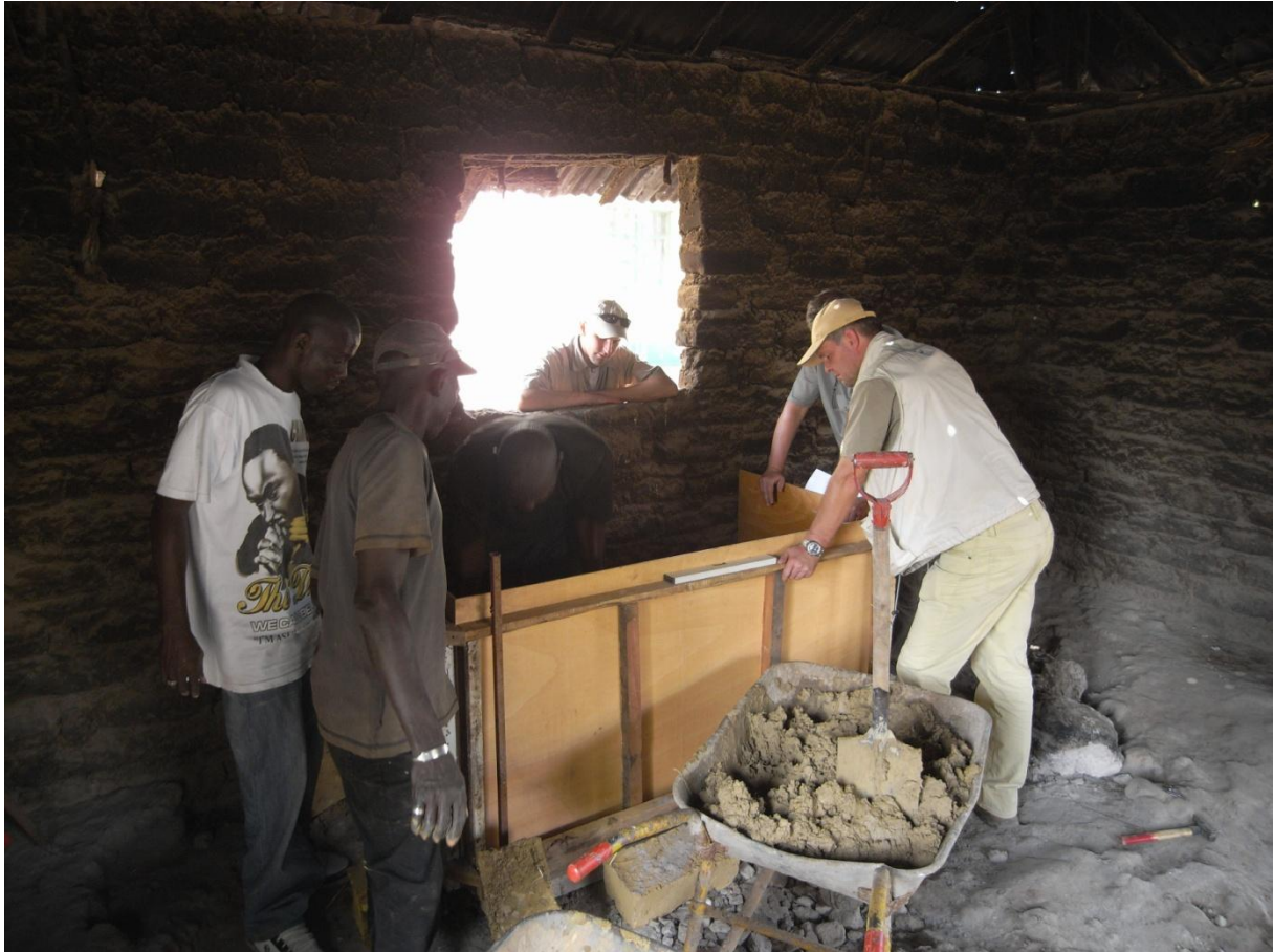
In der Verschalung werden die Lehmziegel gemauert und mit Lehm verputzt
