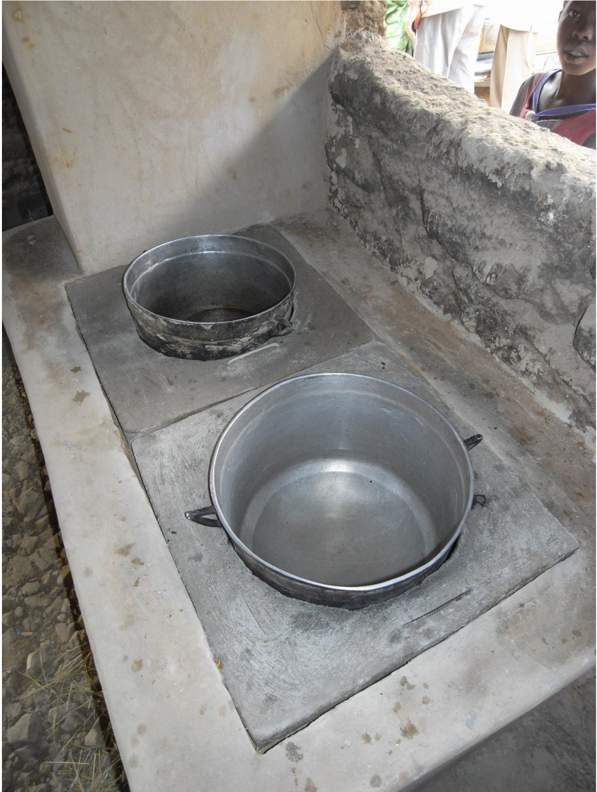
Betonringe ermöglichen das Arbeiten mit Kochtöpfen verschiedener Größen
