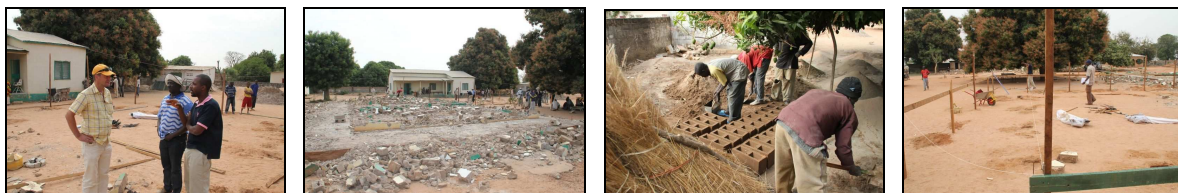
2011: Ketteler auf der Baustelle Alte Gesundheitsstation abgerissen Ziegel-Herstellung in Njaba Kunda Neue Gebäude werden abgesteckt
